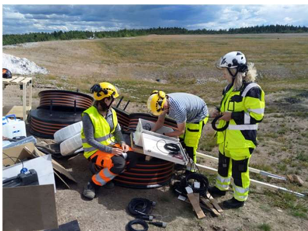
Lysimetrien asennusta valmisteltiin mm. liittämällä sensorit loggausasemaan.
